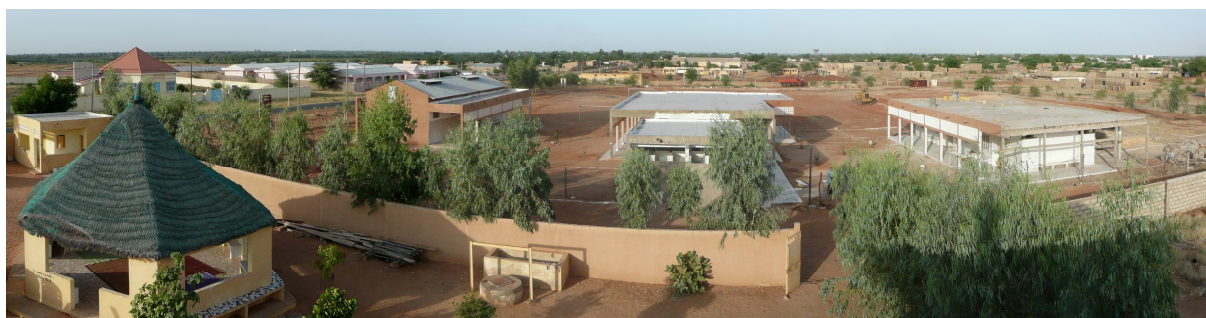
Vue panoramique des trois bâtiments de l'école élémentaire, depuis le toit du centre Morgane
