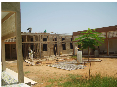
Au fond, le module d'activités en construction
