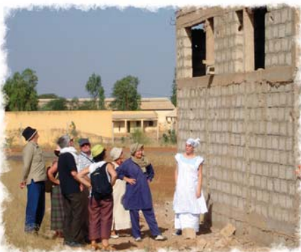
L'école en construction
