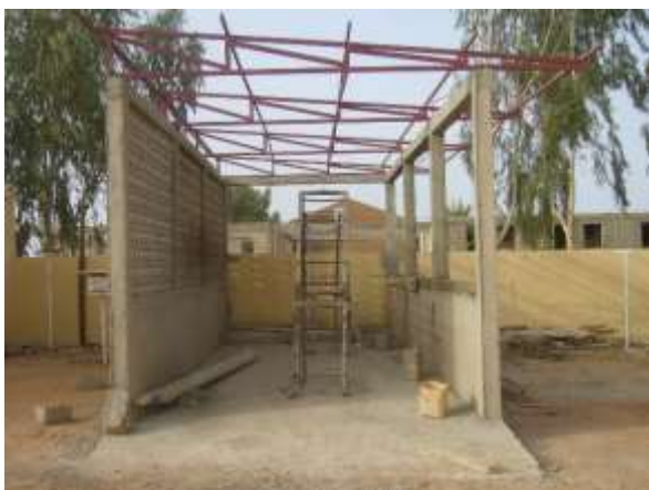
Le abri pour le minibus en cours de construction
