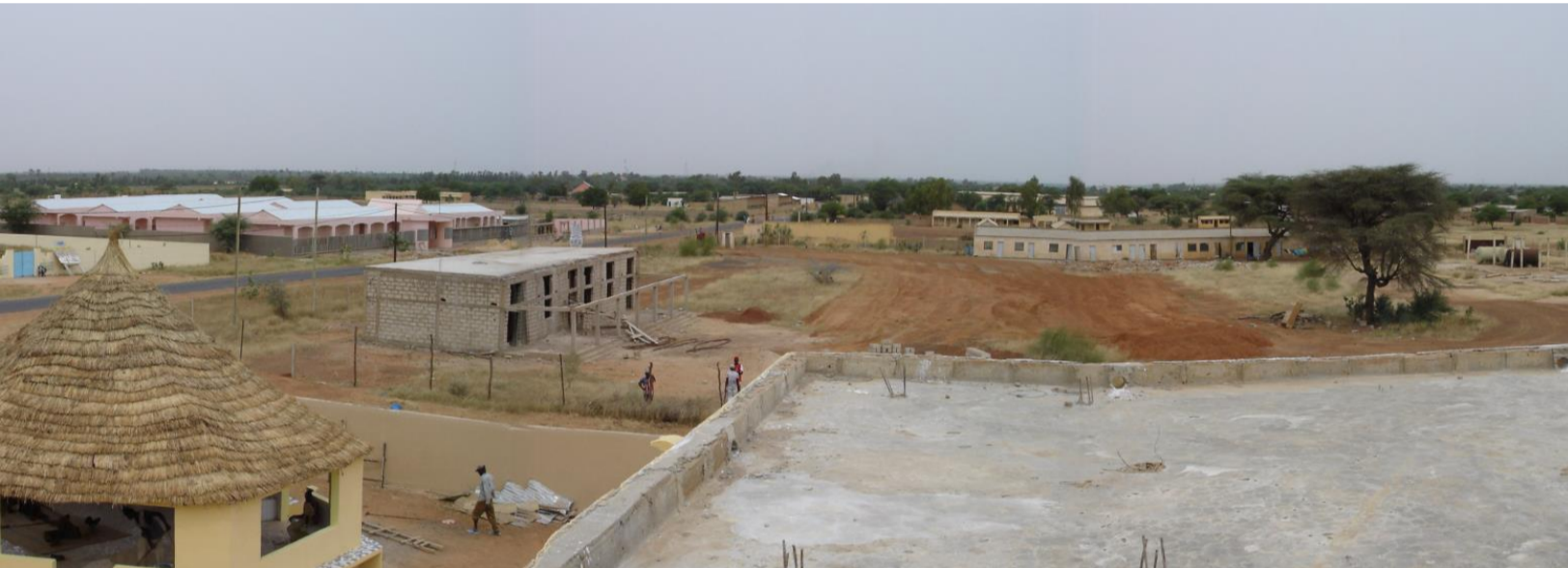
Octobre 2005 : le gros œuvre avance
