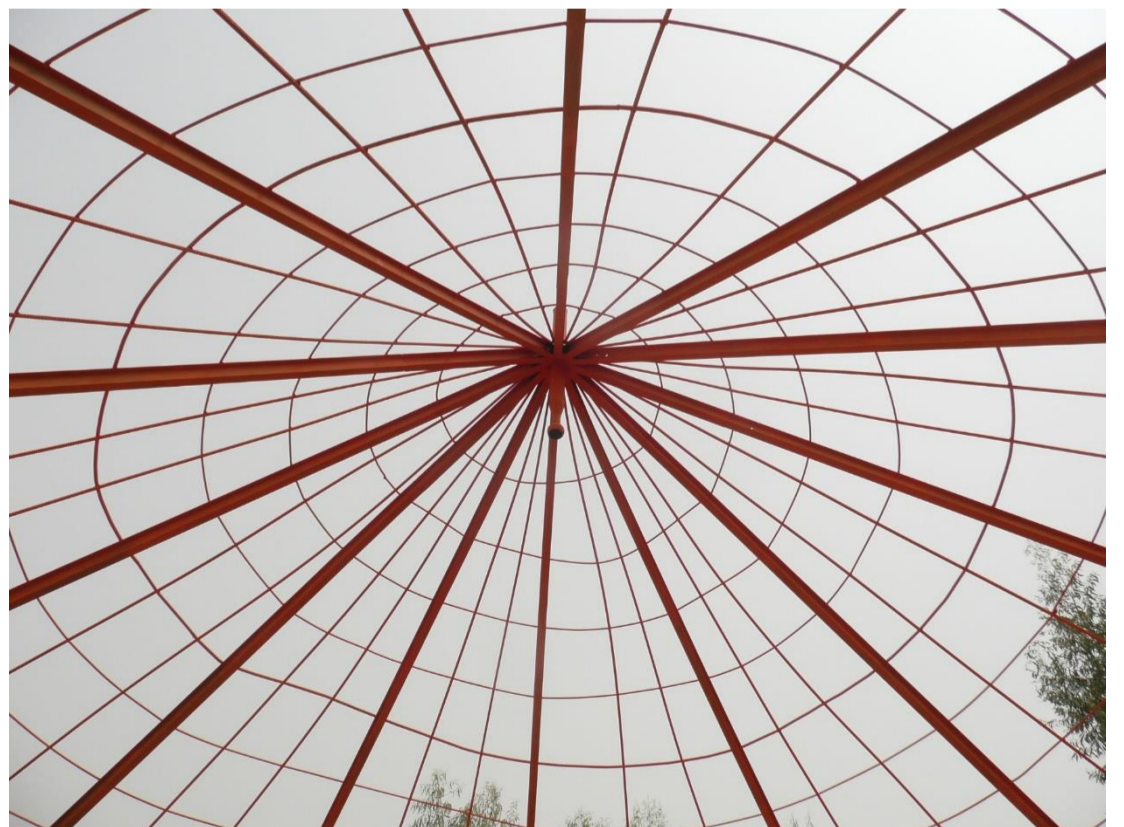
Charpente de la case à palabres
