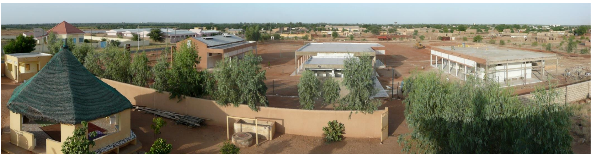
Mai 2008, les deux premiers bâtiments fonctionnent avec leurs quatre classes et les sanitaires. Le troisième est en construction,
