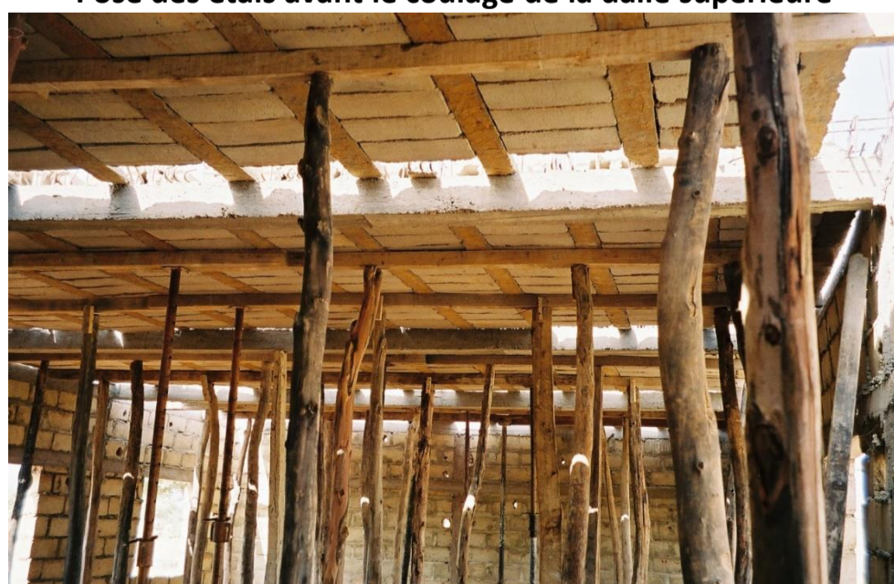
Pose des étais avant le coulage de la dalle supérieure
