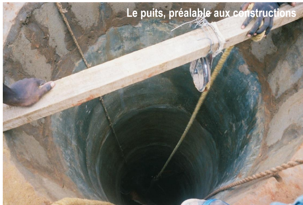
Pose des buses préfabriquées sur place
