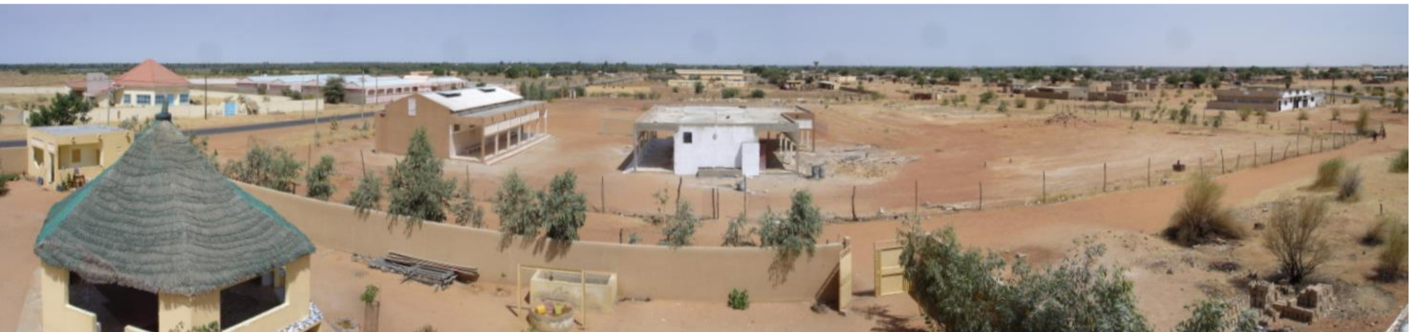
Octobre 2007, le premier bâtiment fonctionne avec deux classes et le second est en construction
