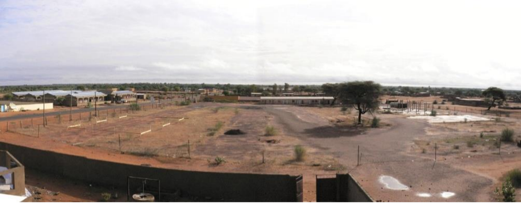
Août 2005 : piquetage du premier bâtiment (en jaune à gauche)
